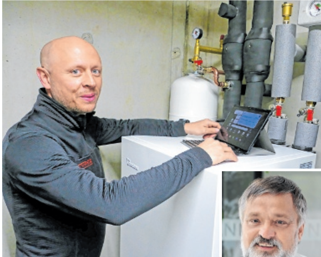
Wärmepumpen – hier im Bild eine neue Anlage in Ferndorf, die Martin Kurz von der Firma Pötz betreut – gehören zu den aktuellen Herausforderungen der SHK-Experten. Foto: Björn Hadem
